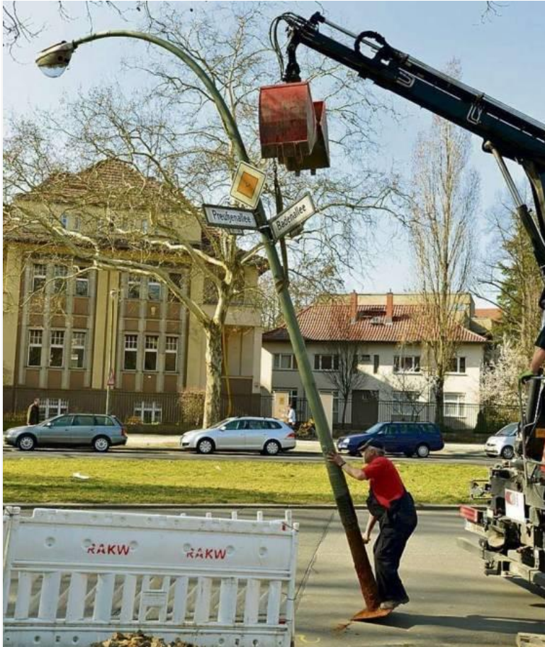
In der Preußenallee wird eine der alten Laternen abmontiert
