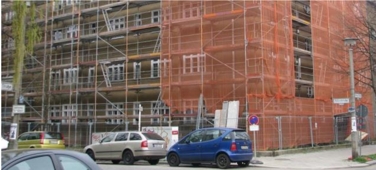
GESOBAU: Sanierungsvorhaben Hallandstr./Trelleborger Str. im Frühjahr 2013
